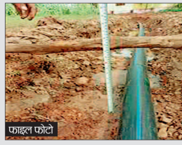
फाइल फोटो एक मीटर की खुदाई कर पाइप लाइन बिछाने का नियम पाइप लाइन बिछाने के लिए एक मीटर की खुदाई करने का नियम है। इस नियम के तहत ही पाइप लाइन बिछाया जाता है। - अविनाश एक्का, सब इंजीनियर, तिल्ला
